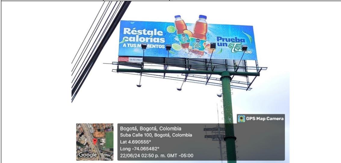
Foto 2. Vista del panel orientación SUR - NORTE y de la estructura de la valla, en buenas condiciones y estable.
